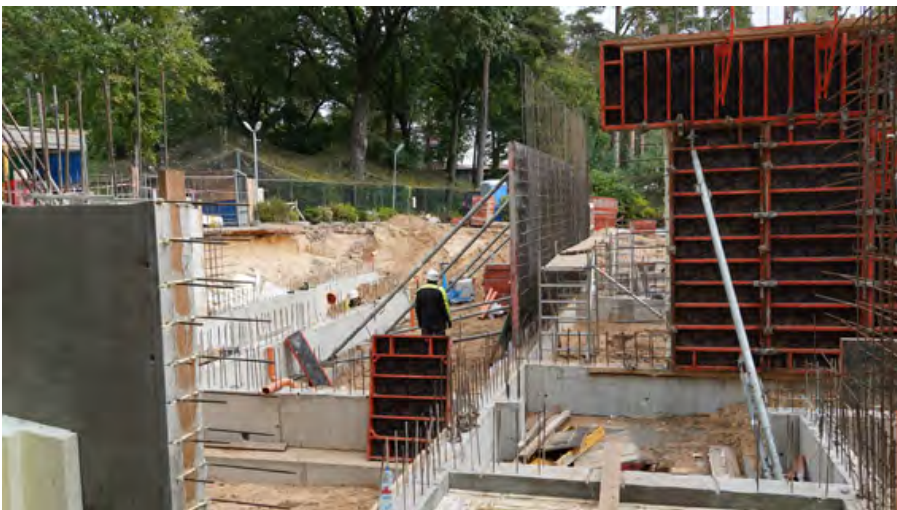
Telpas ventilācijas iekārtām un tualetēm
